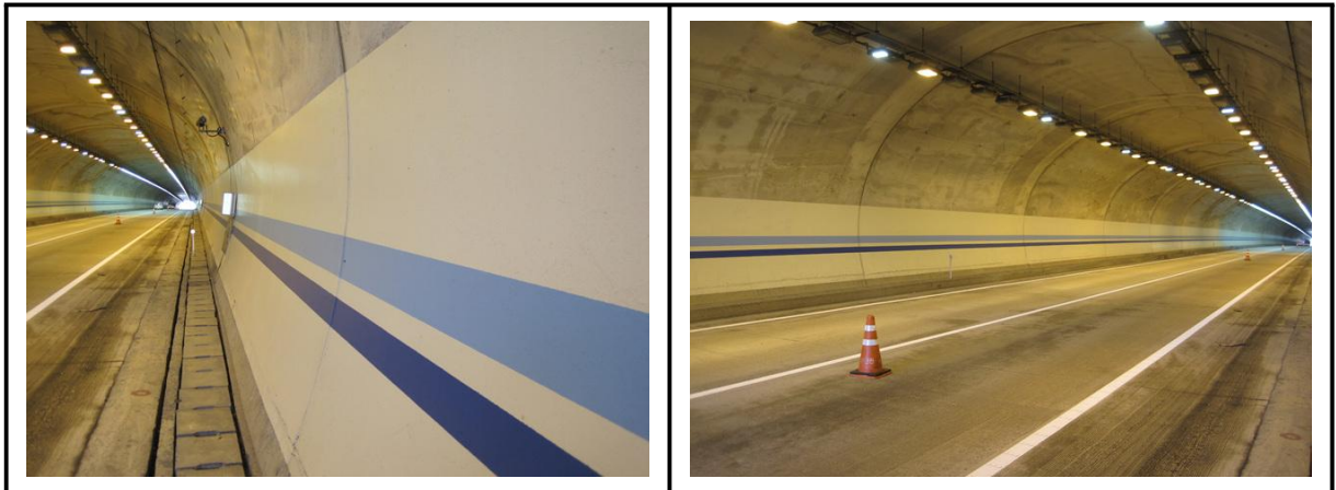
【사진 4.3.17】 라이닝 측벽부 전경
