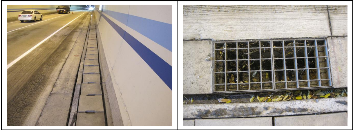
【사진 4.3.23】 공동구 및 배수시설 전경
