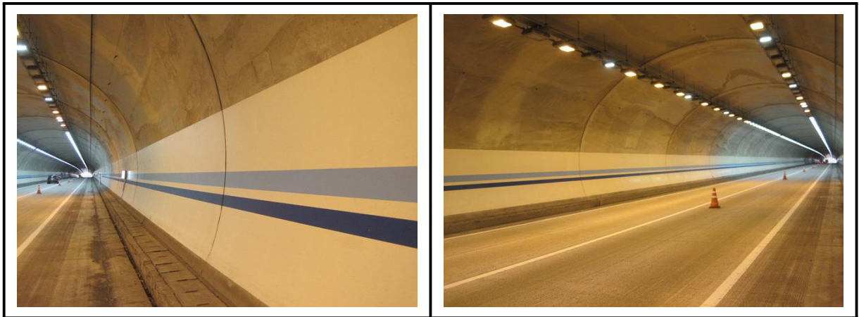
【사진 4.3.3】 라이닝 측벽부 전경
