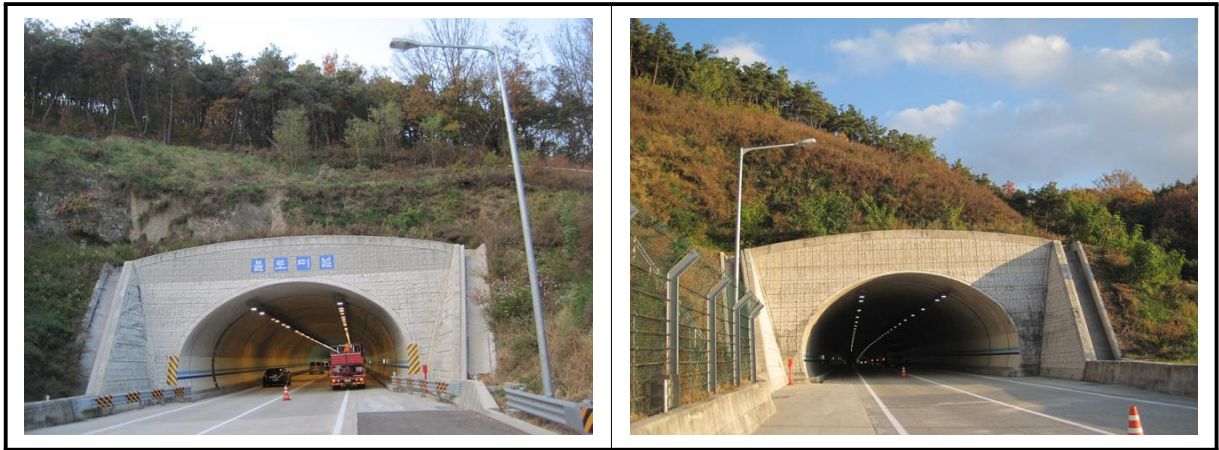
【사진 4.3.7】 사면 전경
