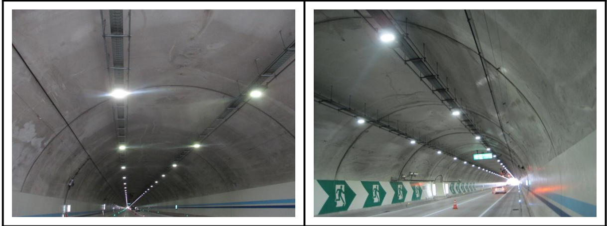
【사진 4.3.15】 라이닝 천단부 전경
