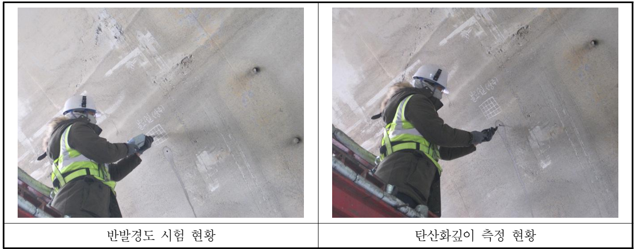
【사진 4.4.1】 콘크리트 내구성조사 현황
